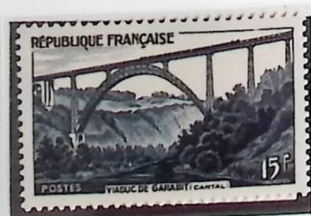
VIADUC DE GARABIT
