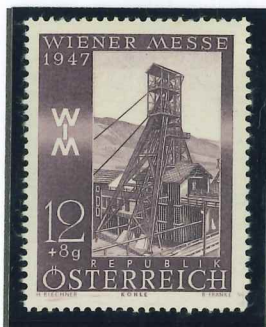
Franzens-schacht im west- steirischen Braunkohlenrevier
