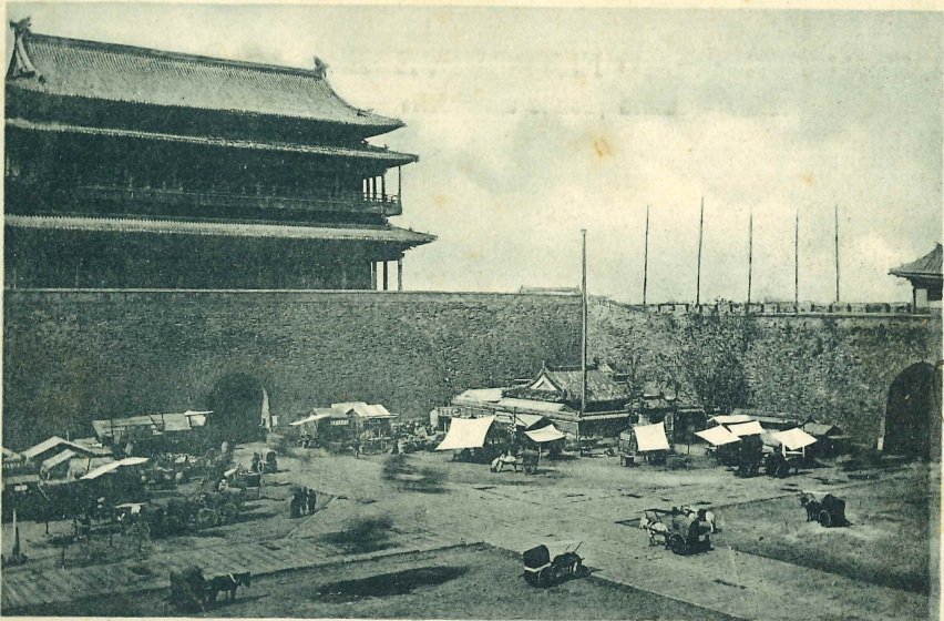
An der Stadtmauer von Peking - 29-8-92
