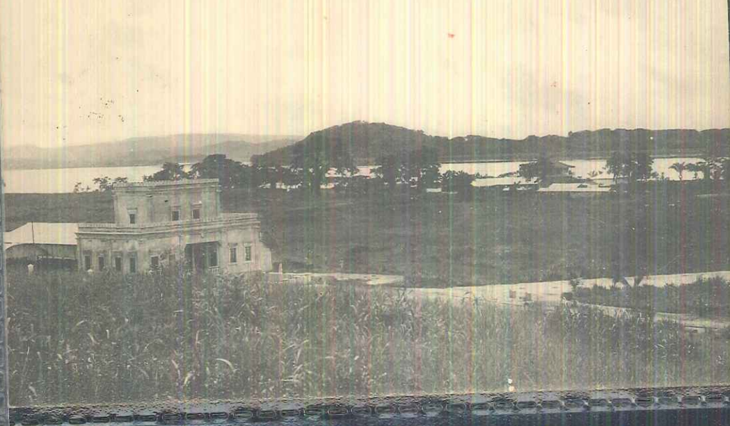
25 Congo Belge Belgisch Congo Gare du Mayumbe. Statie van Mayumbe.
