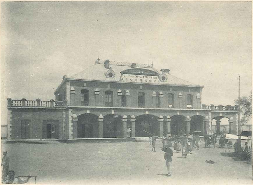
Hankow. — Gare du Chemin de fer de Pékin. The Peking railway station.— Bahnhof der Eisenbahn nach Peking
